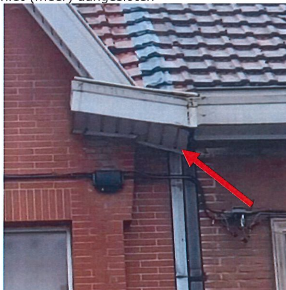
Schadebeeld 006 – RWA-afvoer verstopt of niet (meer) aangesloten
