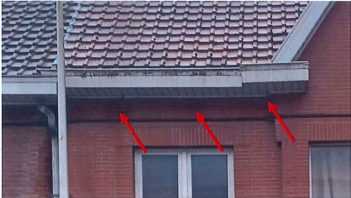
Schadebeeld 002 – rechtergedeelte dakgoot dreigt af te breken
