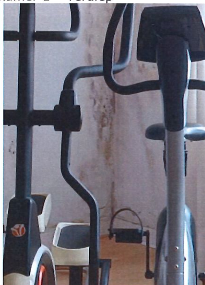
Schadebeeld 008 – doorslaand vocht in slaapkamer 1 ste verdiep
