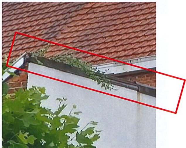
Schadebeeld 012 – afwerkings-, druij-, afdichtingsprofiel ontbreekt
