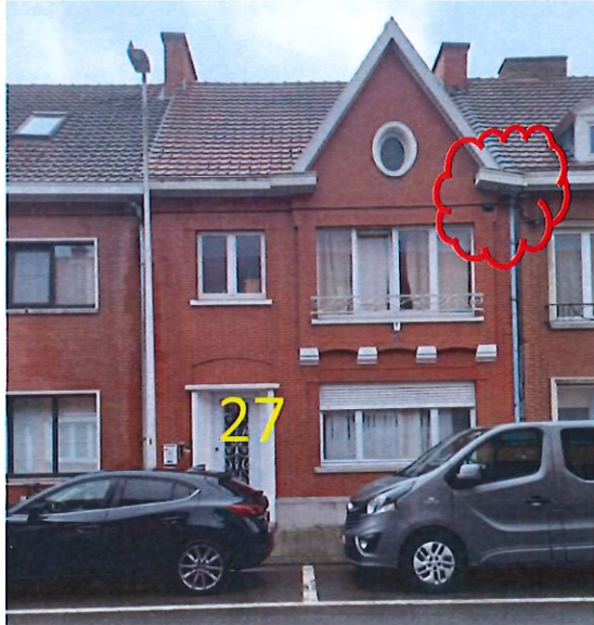
Schadebeeld 006 – RWA-afvoer verstopt of niet (meer) aangesloten
