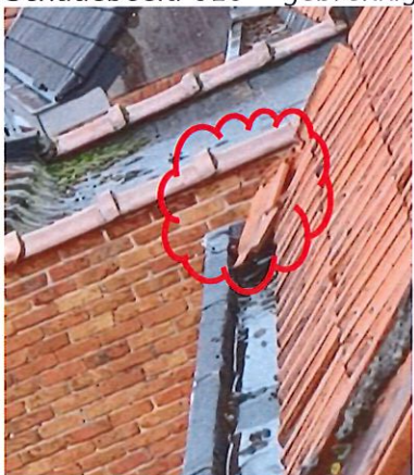
Schadebeeld 010 – gebrekkig onderhoud van het dak zowel aan voor- als achterzijde
