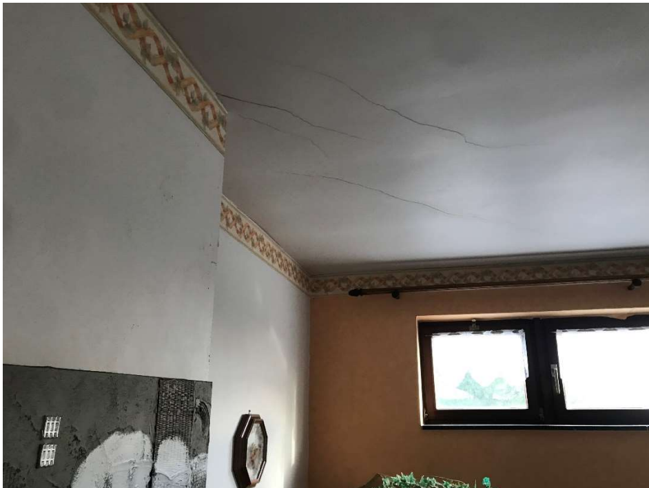
Figure 22 : Fissures H.1
