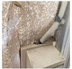
Des interrupteurs et/ou boîte de dérivation ne sont pas conformes. (5.3.5.2.;5.3.5.4.)
