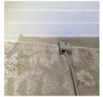
L'utilisation de douilles pour alimenter un point d'éclairage dans l'attente de l'appareil d'éclairage définitif n'est autorisée (4.2.4.3.a)
