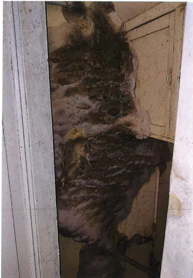
Accès vers sous-sol
