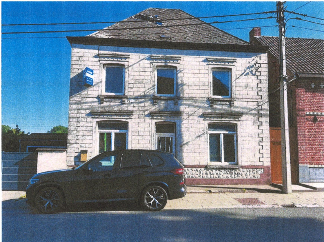
Figure 1 : Façade de l'habitation
