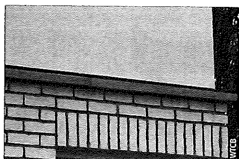
Afb. 82 Aansluiting van een ETICS met een spouwmuur.
