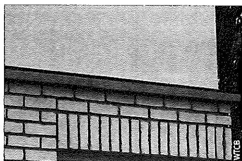
Afb. 82 Aansluiting van een ETICS met een spouwmuur.
