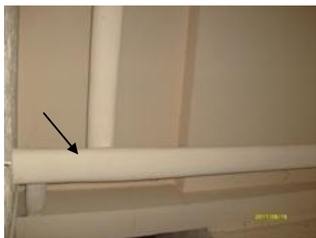
Photo 31 (calorifuge – cage d'escalier)
