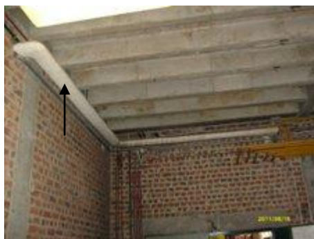
Photo 28 (calorifuge – cartonnerie)
