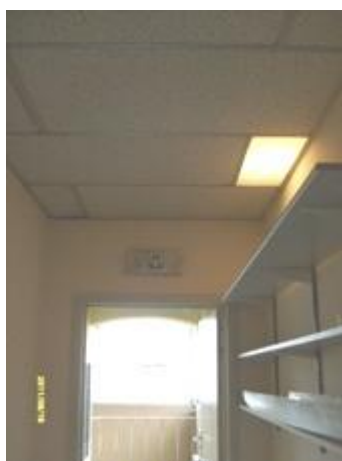
Photo 38 (dalle faux plafond +1 – idem 001)
