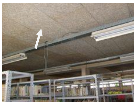
Photo 43 (sous-toiture – stock bibliothèque)
