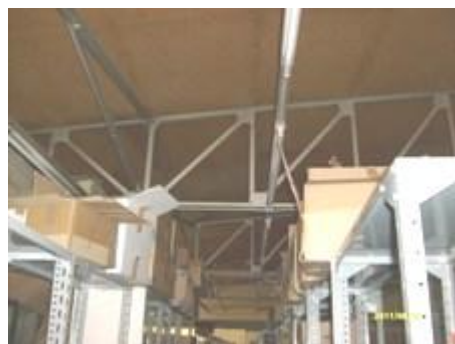
Photo 42 (sous-toiture non suspect – stock bibliothèque)
