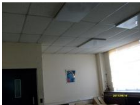
Photo 39 (dalle faux plafond +1 – idem 001)
