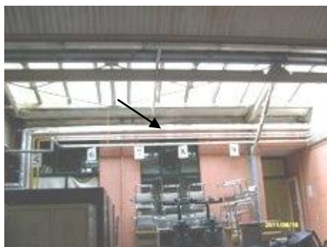
Photo 19 (calorifuge – quai zone gauche)
