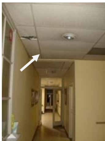
Photo 8 (dalle faux-plafond, rez-de-chaussée)
