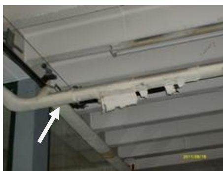
Photo 30 (calorifuge – partie droite du quai)
