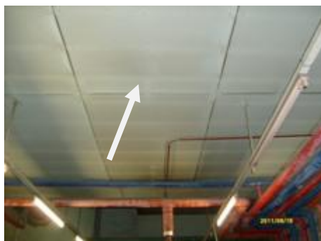
Photo 27 (menuiserit – local chaufferie)
