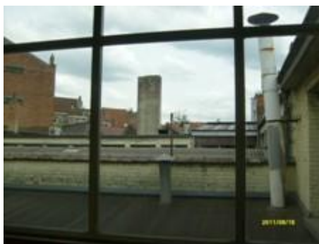
Photo 40 (vue toiture zone centrale – rien à signaler)
