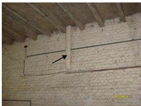
Photo 11 (calorifuge – niv. 0)
