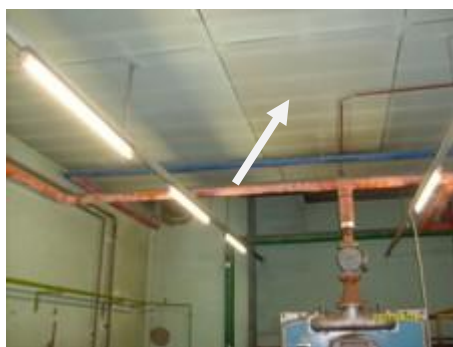
Photo 26 (menuiserit – local chaufferie)
