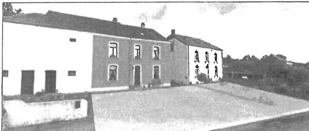
FIGURE 4 : LES FOSSÉS - RUE DES COMBATTANTS
