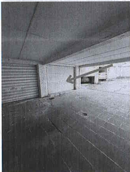
Box de garage "G7" (non accessible lors de la visite)
