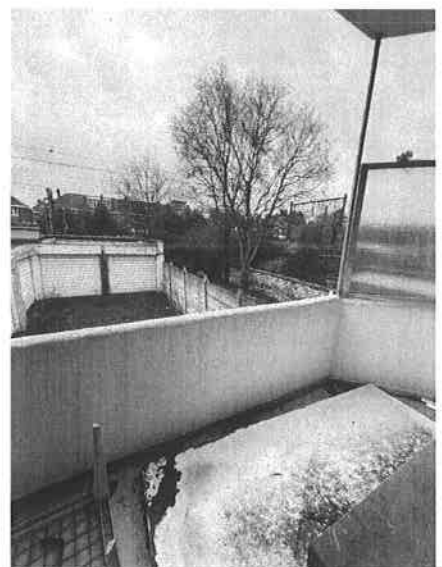
Balcon en façade arrière
