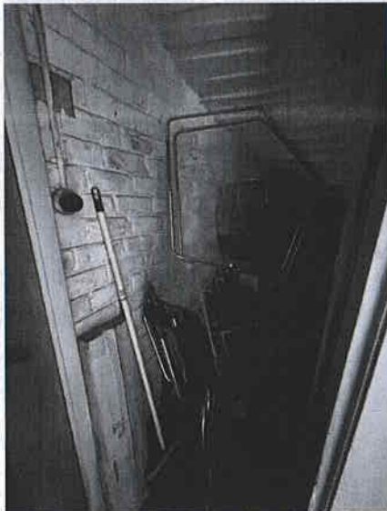
Cave "C3" (sous l'escalier du hall d'entrée commun)
