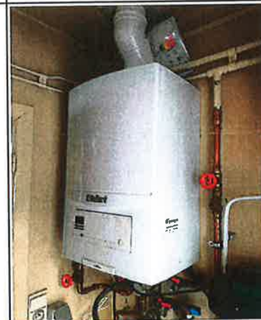
Foto 25: condensatieketel type C
