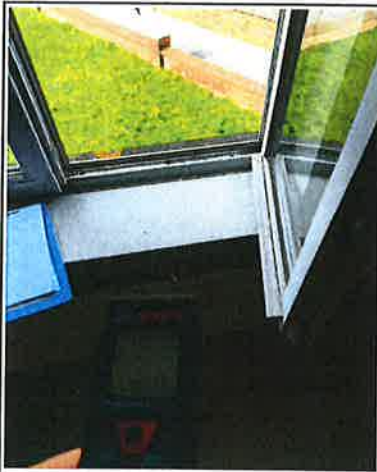
Foto 14: 171: trappen, overlopen, borstweringen met gebruiksonveilige elementen ( te steil / gebreken ...) / trap naar een woonfunctie ontbreekt
