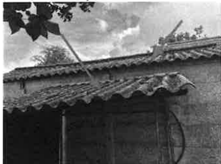
Abri de jardin - / - Toiture
