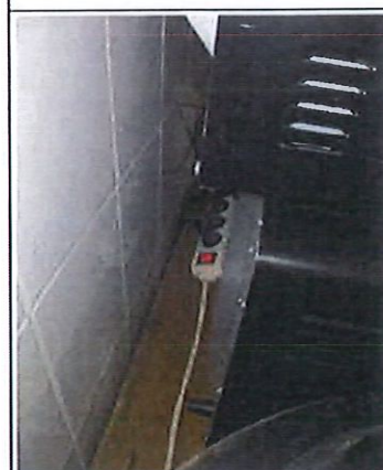
Foto 12: 51: indicatie van een risico op elektrocutie/brand Meerdere toestellen klasse 1 (oven, microgolfoven) aangesloten op verdeelstekker.
