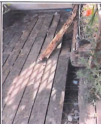
Foto 35: 232: de woning is niet veilig toegankelijk (bv. gebreken aan gemeenschappelijke gangen, trappen...) Ontbrekende, losliggende en rotte planken terras,
