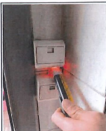
Foto 8: 51: indicatie van een risico op elektrocutie/brand Loshangende bedrading onder spanning
