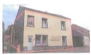
Le volume protègé d'un logement reprend tous les espaces du logement que l'on souhalte protèger des déperditions thermiques que ce solt vers l'extérieur, vers le sol ou encore des espaces non chauffés (cave. annexe, bâtiment mitoyen...). Il comprend au moins tous les locaux chauffés. Lorsqu'une paroi dispose d'un isolant thermique, elle délimite souvent le volume protègé.
