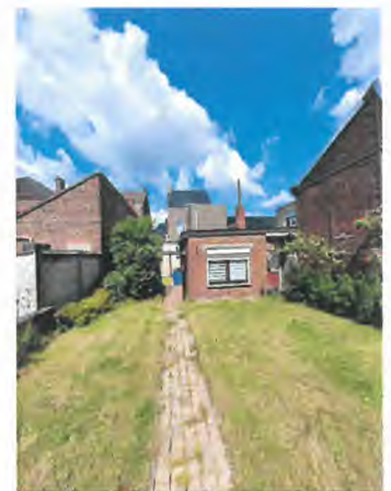
Façade arrière vue 2
