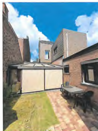
Façade arrière vue 1
