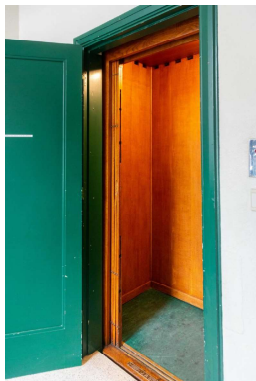
Rue Meyerbeer 126. Intérieur de la cabine © Homegrade, 2022
