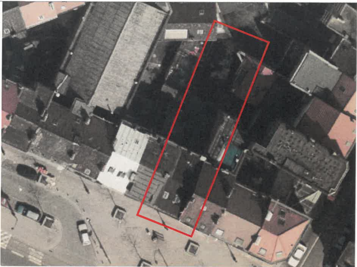
Photo 100 - Vue aérienne - 1996 source BruGIS® - les volumes sont en place (excepté l'auvent qui arrivera en 2020)
