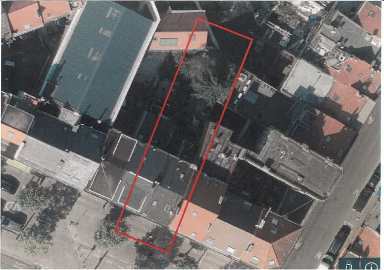
Photo 102 - Vue aérienne - 2020 source BruGIS® - L'auvent est construit.
