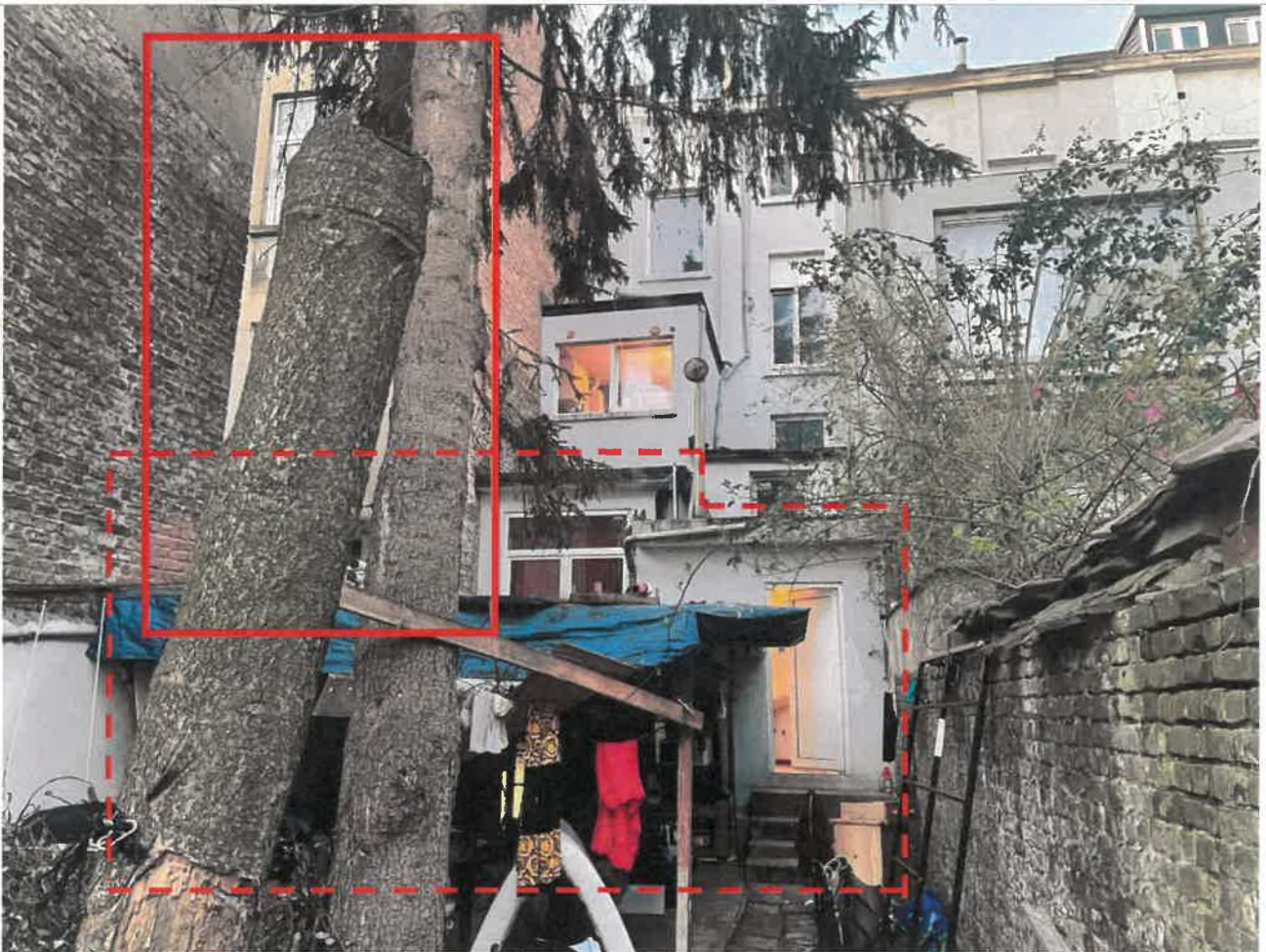
Photo 35- Vue après le lever du soleil (fin de visite du bâtiment).
