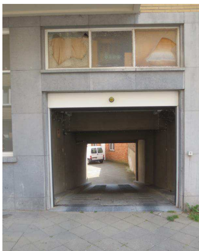
Photo 2 : Vue de l'entrée du parking
