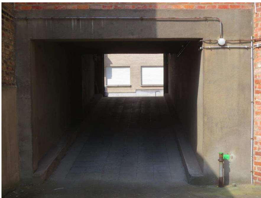
Photo 3 : Vue du point de remplissage présent dans le parking
