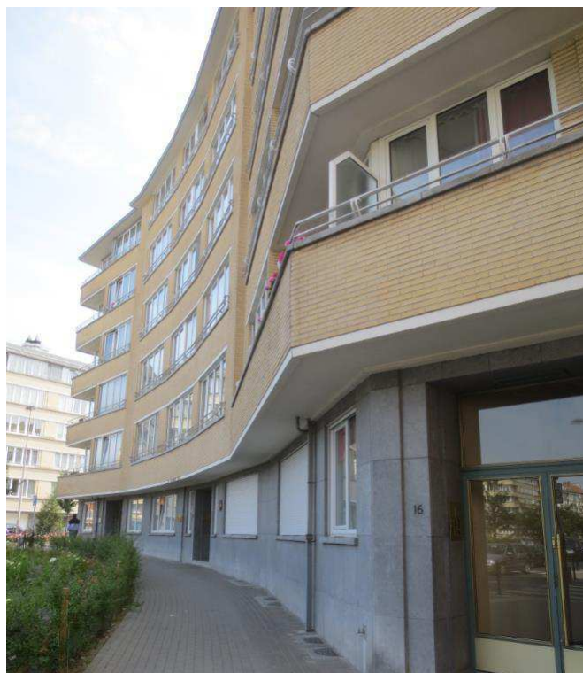
Photo 1 : Vue du bâtiment
