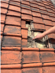
Toiture bois.jpg 2874K
