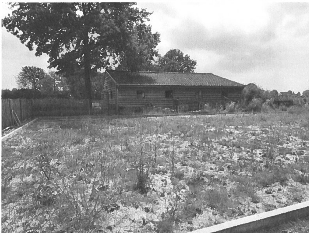
Bron: plaatsbezoek dd. 27/06/24 – zicht op de herbouwde stal
