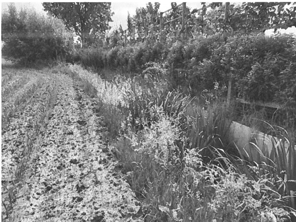
Bron: plaatsbezoek dd. 27/06/24 – zicht op de geplaatste betonelementen in de gracht
