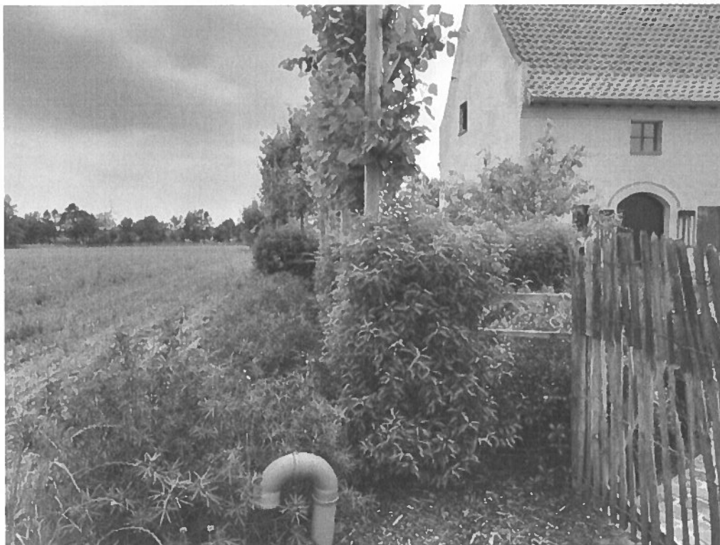
Bron: plaatsbezoek dd. 27/06/24 – zicht op de voorzijde van de woning en op de gracht die deels werd overwelfd en waarbij een uitsprong werd gemaakt op het naastliggende perceel
