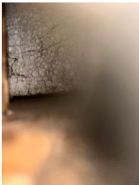
isolation toiture principale EPS
