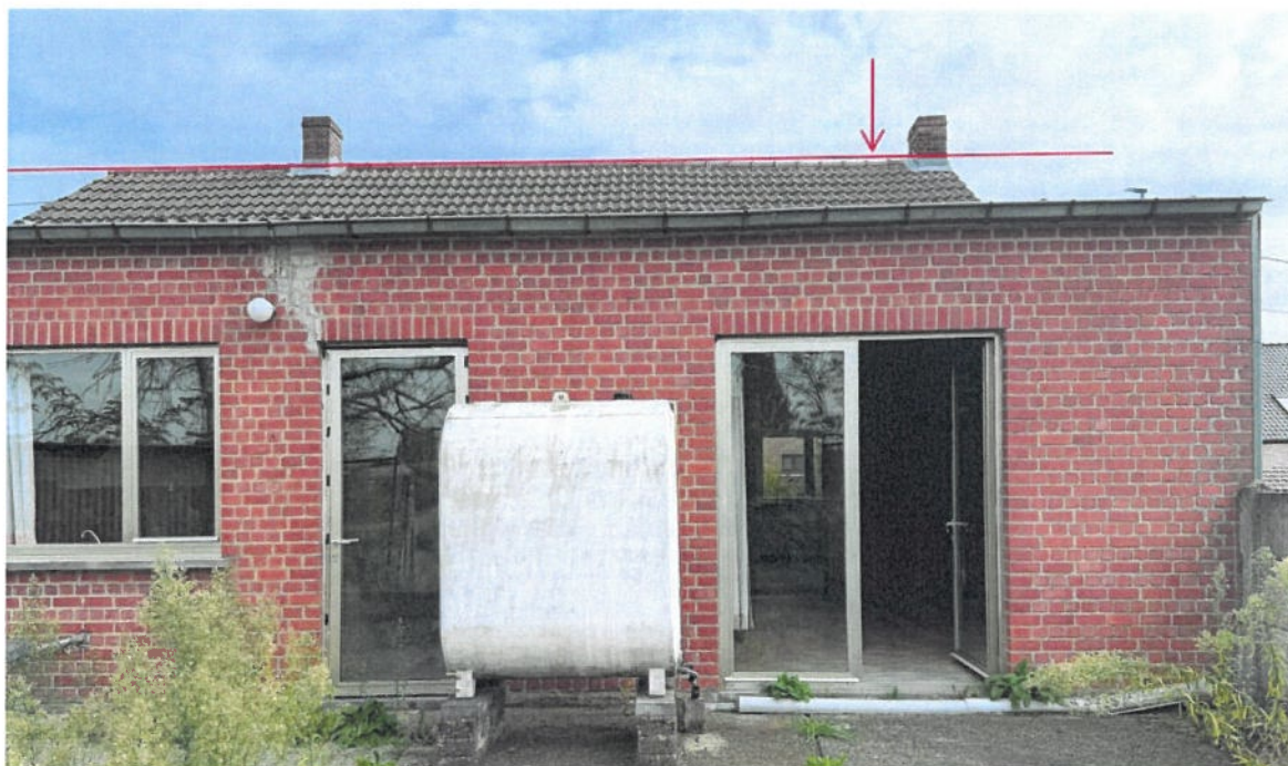
On observe le déplacement vertical de l'appui du faîte
