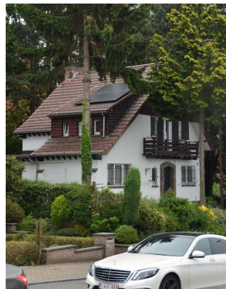
Rue Profonde 413, ARCHistory / APEB, 2018
