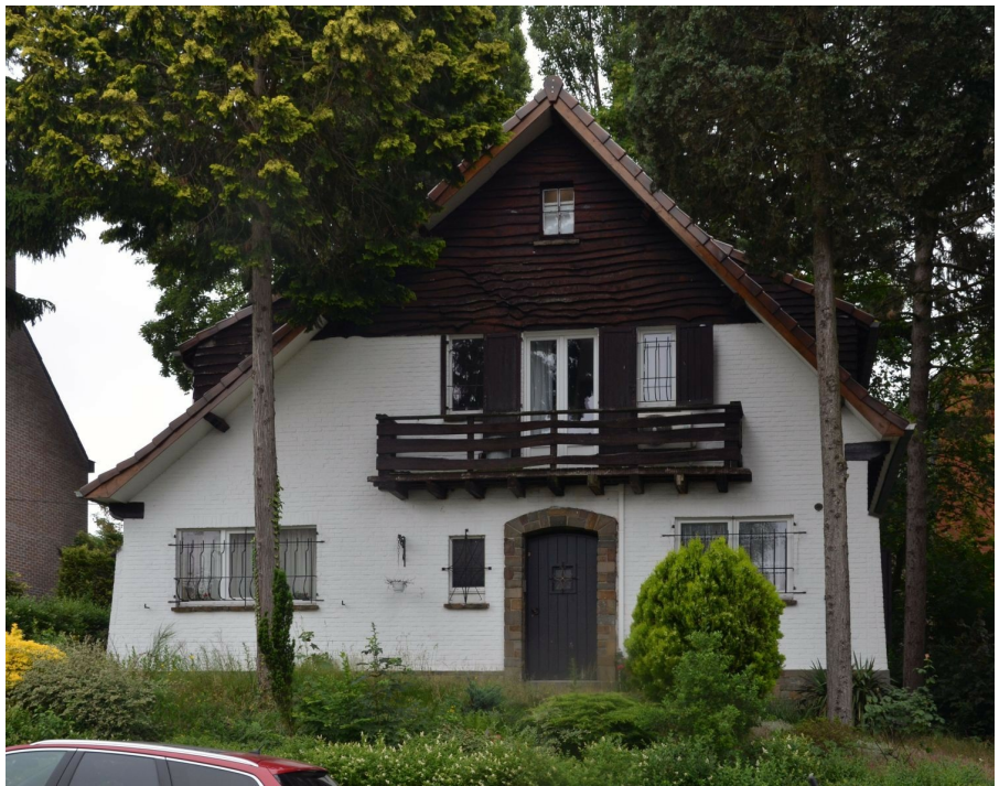
Rue Profonde 413, ARCHistory / APEB, 2018
