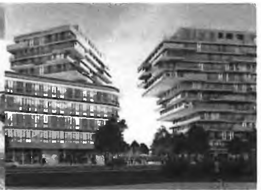
WATERFRONT Waregem Réseau de chaleur
