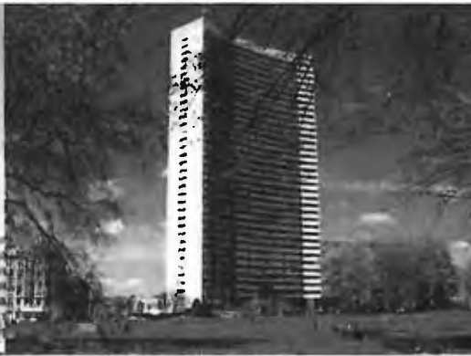
TOUR BRUSILIA Schaerbeek Cogénération
