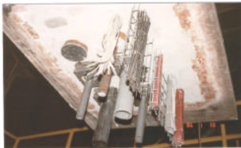
Vóór de proef : de blootgestelde zijde van het proefelement
