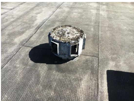
Bron 21 : verluchtungskokers (asbestcement)
