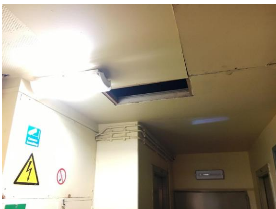
Bron 15 : plafondplaten (asbestcement)
