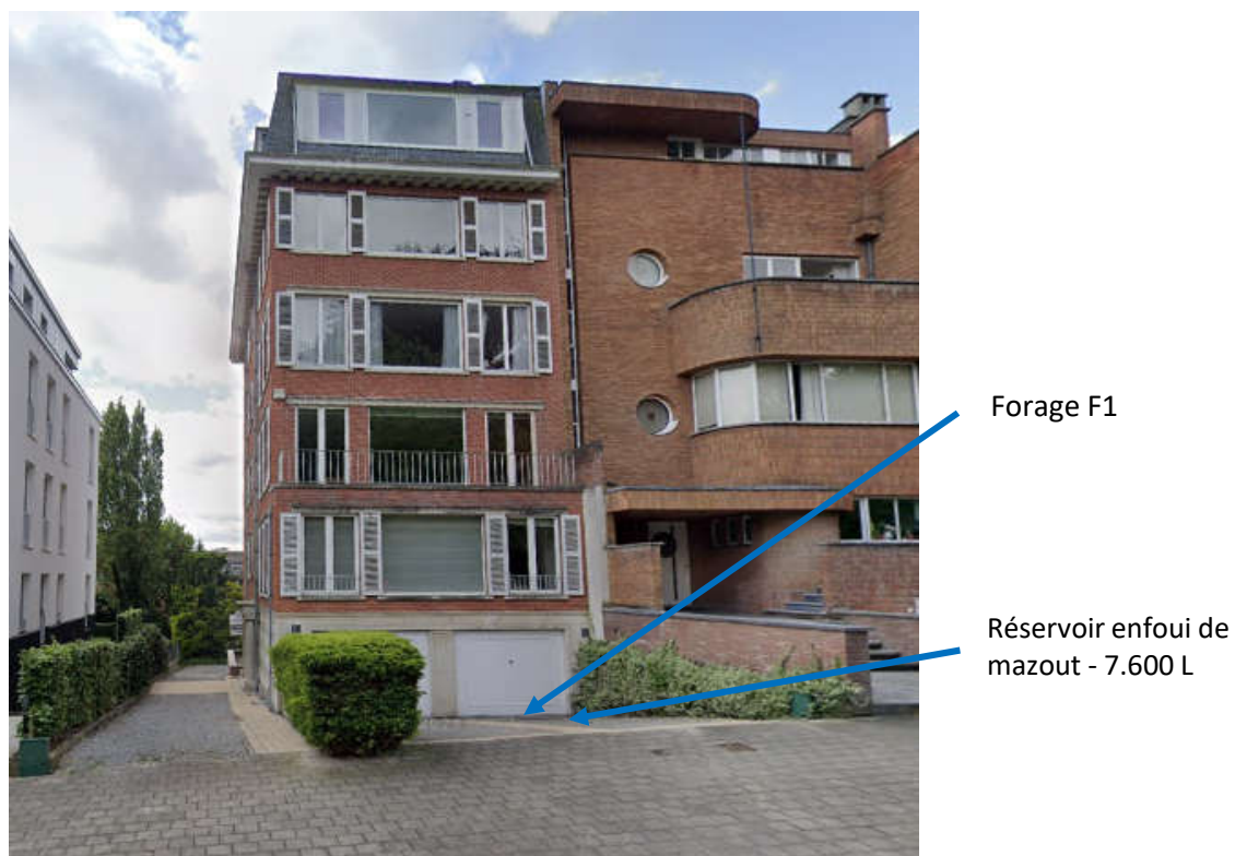
Photo P1 : réservoir R1 et position des forages
