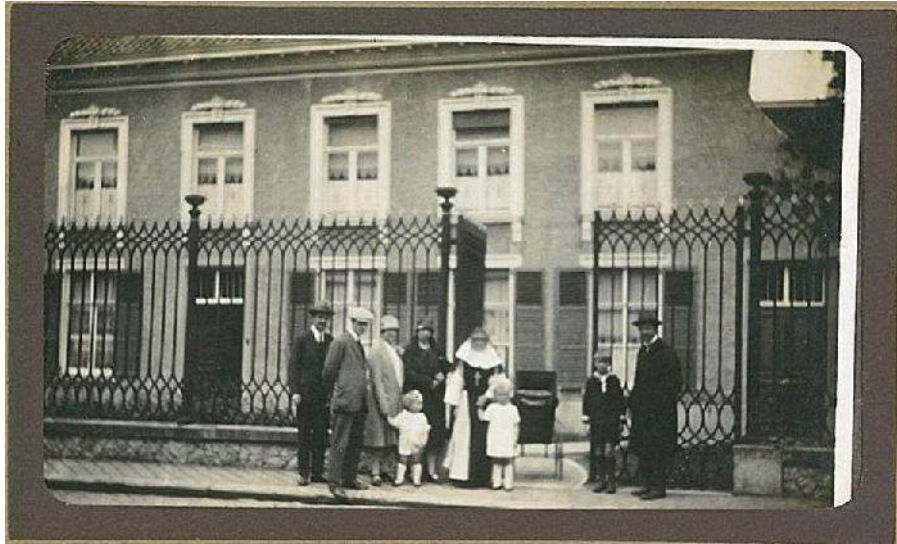
Op deze foto is het nieuwe schrijnwerk op de verdieping wit geschilderd. Het hekwerk is zwart geschilderd.
