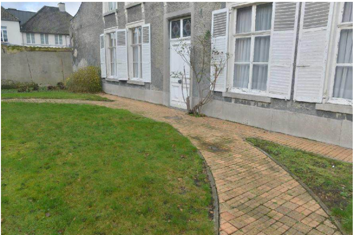
Halfcirkelvormig breed toegangspad en smallere stoep uit gebakken aardetegels met vakverdeling tussen een op maat gemaakte afboording uit Belgische blauwe hardsteen met gefrijnde bovenzijde. In behoorlijke staat, op diverse plaatsen zijn er wel verzakkingen merkbaar. Links van de voordeur staat een winterjasmijn ( Jasminum nudiflorum ), rechts van de deur een rozenstruik.
