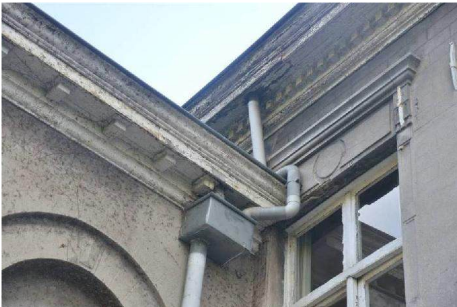
Grote kroonlijst met tandlijst achterzijde hoofdgebouw en kleinere t.h.v. de dwarse vleugel. Schraal verwerk en plaatselijke schade t.h.v. de afvoeren. Verouderde zink met afvoeren in PVC.
