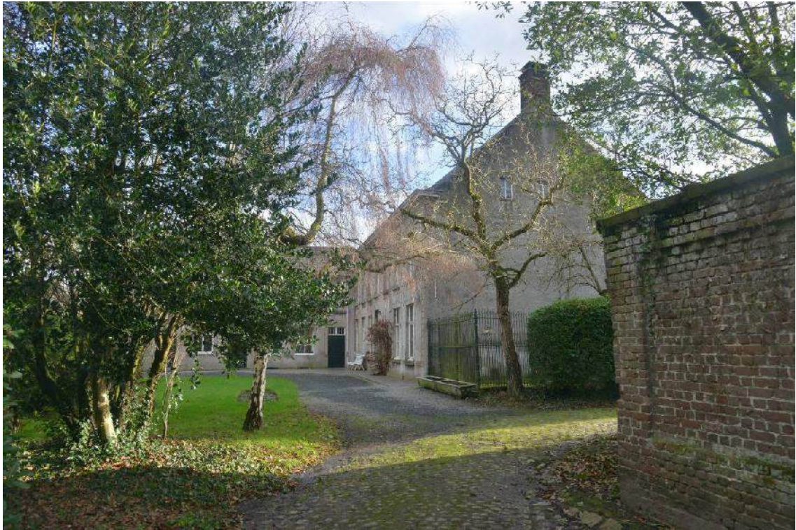
Aansluitend aan de linkse oprit brede verharding in grind kant woning.
