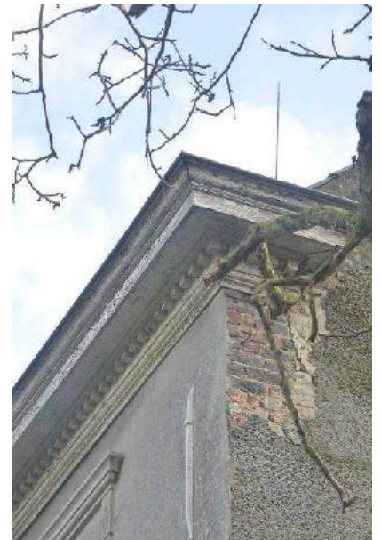
Grote kroonlijst met tandlijst achterzijde hoofdgebouw en kleinere t.h.v. de dwarse vleugel. Schraal verwerk en plaatselijke schade t.h.v. de afvoeren. Verouderde zink met afvoeren in PVC.
