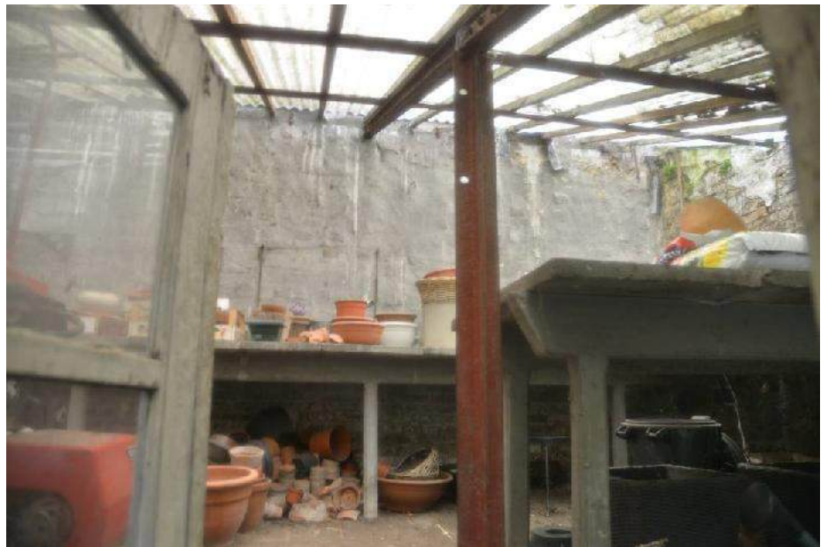
Foto links van de lage aanbouw die los staat van de kennel. Voorzijde van de aanbouw is gecementeerd. Algemene verweerde toestand.
