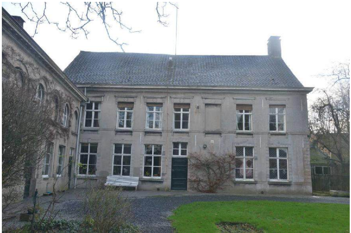
T.h.v. de woning aan beide gevels een voetpad en in t.h.v. de binnenhoek driehoekig terras, beiden in betondallen. Goede staat.
