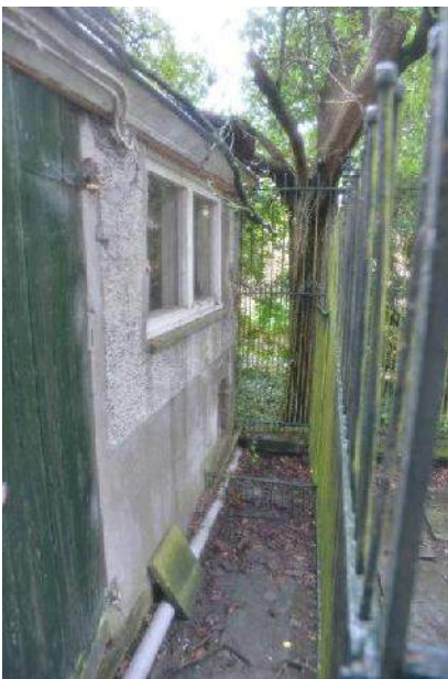
Foto links van de lage aanbouw die los staat van de kennel. Voorzijde van de aanbouw is gecementeerd. Algemene verweerde toestand.
