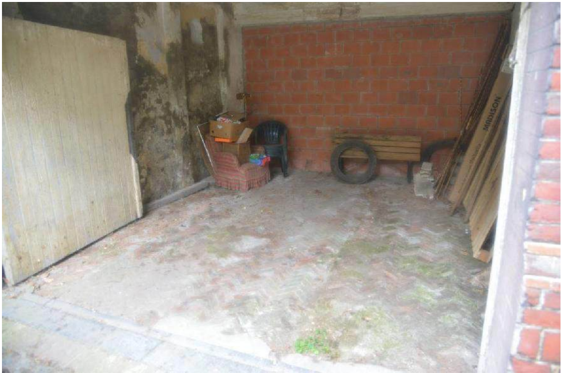
Foto van het linkse koetshuis met achteraan dichtgemaakte vroegere doorgang, cfr. archiefplan zie hoger. Behouden baksteenvloer in V-vorm geplaatst.
