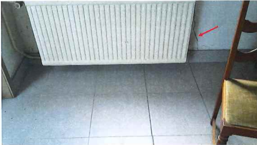
Figuur 18 : Schadebeeld n° 8 : scheurvorming in binnenpleisterwerk
