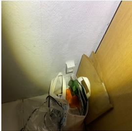
– Des conducteurs du type VOB ne sont pas placés sous conduit et/ou comme il se doit. (5.2.9.)
