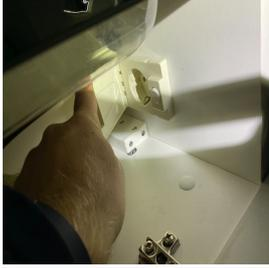
– Il manque des rosaces derrière les prises et/ou interrupteurs en nécessitant. (1.4.)
