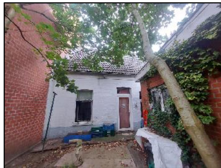
Figuur 5: Foto van de achtergevel
