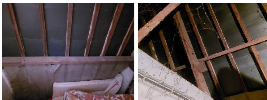
Figuur 10: originele stijlen en vernieuwde sporenkap
