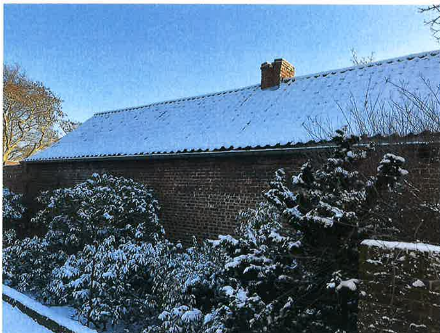
Vue latérale du bâtiment Nord
