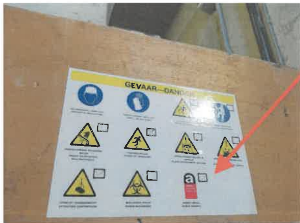
Figuur 3: In de doorgang naar het dak werd reeds aangeduid dat er asbesthoudende toepassing aanwezig zijn voorbij dit punt.
