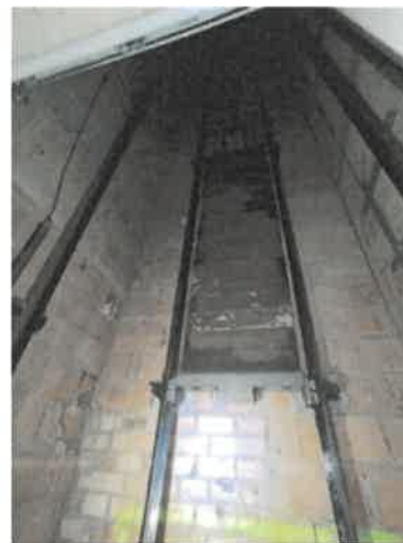
Figuur 4: De liftschaft werd gecontroleerd, geen asbest.
