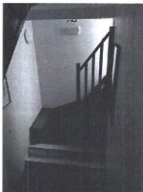
Annexe après travaux
