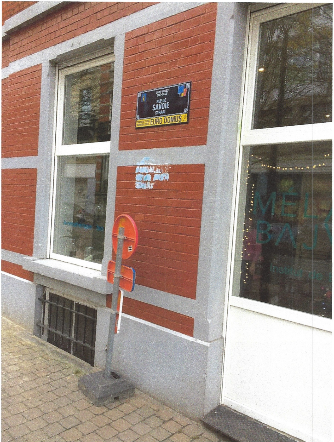
QUARTIER AÛTOUR de VILLES. Rue de SAVOIE n°1
