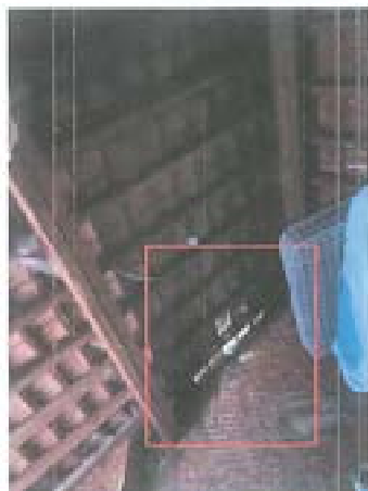
Vue de la toiture avec tuiles manquantes côté immeuble de la partie demanderesse.
